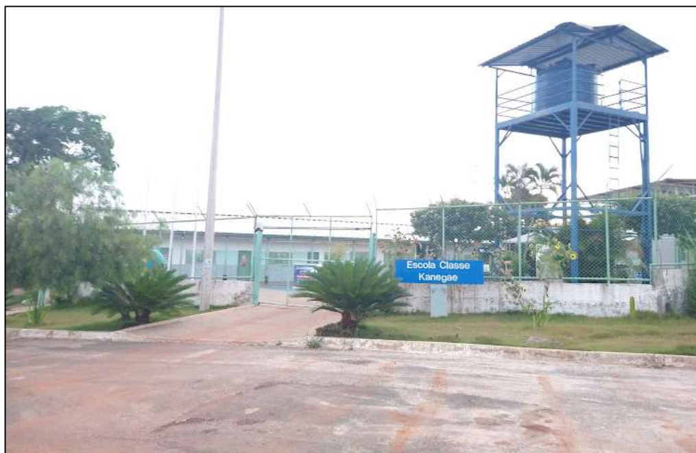
Figura 08: Foto da área externa da Escola Classe Kanegae na CAK.
