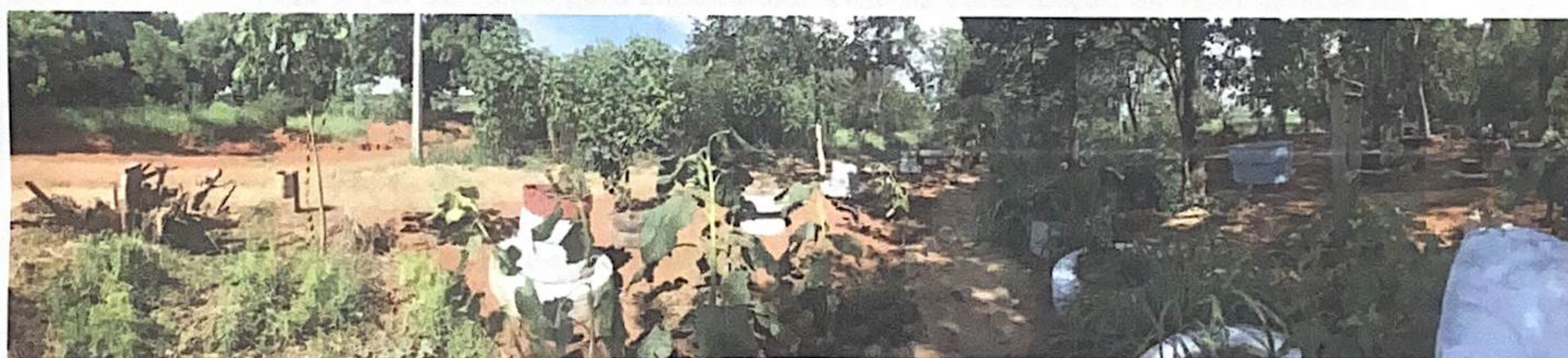
Figura 06 - Imagem panorâmica do jardim em construção
