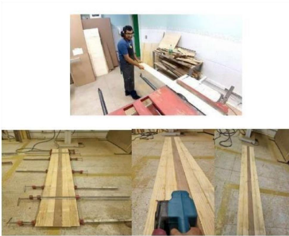
Figura 12: Fabricação do deck
