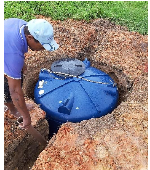
Figura 6: instalação do tanque no poço
