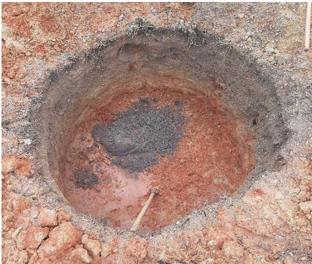
Figura 5: poço devidamente escavado
