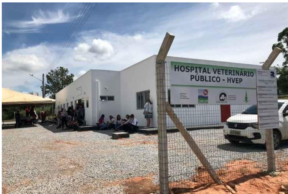
Figura 5 – Hospital Veterinário Público de Taguatinga
