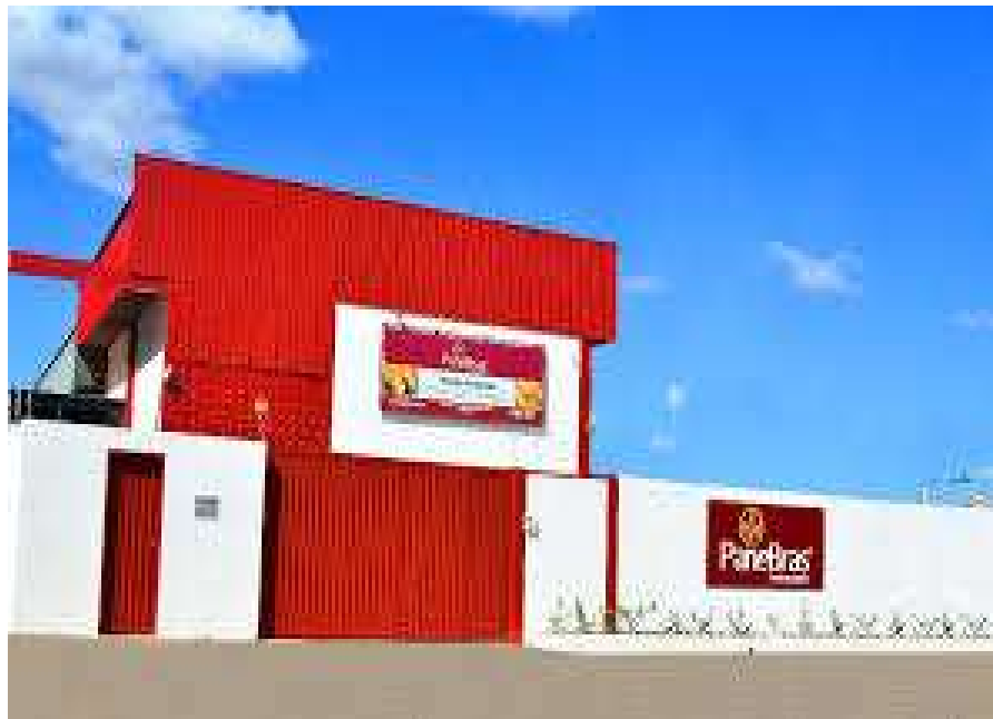
Figura 2: Fachada da empresa PANEBRÁS
