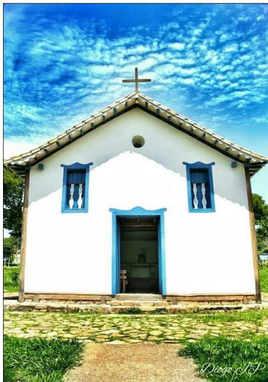
Figura 1 - Igrejinha de São Sebastião
