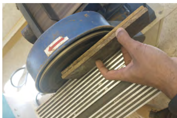
Figura 81: Retirada de Piche na base dos tacos, para a etapa de desengrosso.
