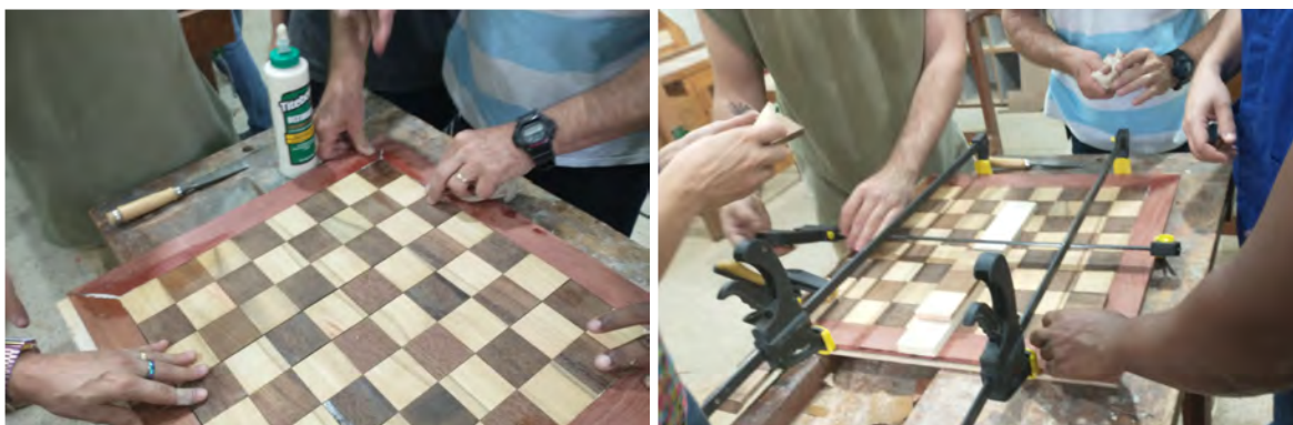
Figura 60 e 61: Processo de colagem da moldura por adesivo PVAc e fixação por meio de sargentos.
