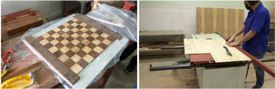
Figura 49 e 50: Após tempo de cura do adesivo, obtemos tabuleiro sem moldura e fundo, foi feito corte do compensado para base na esquadrejadeira.
