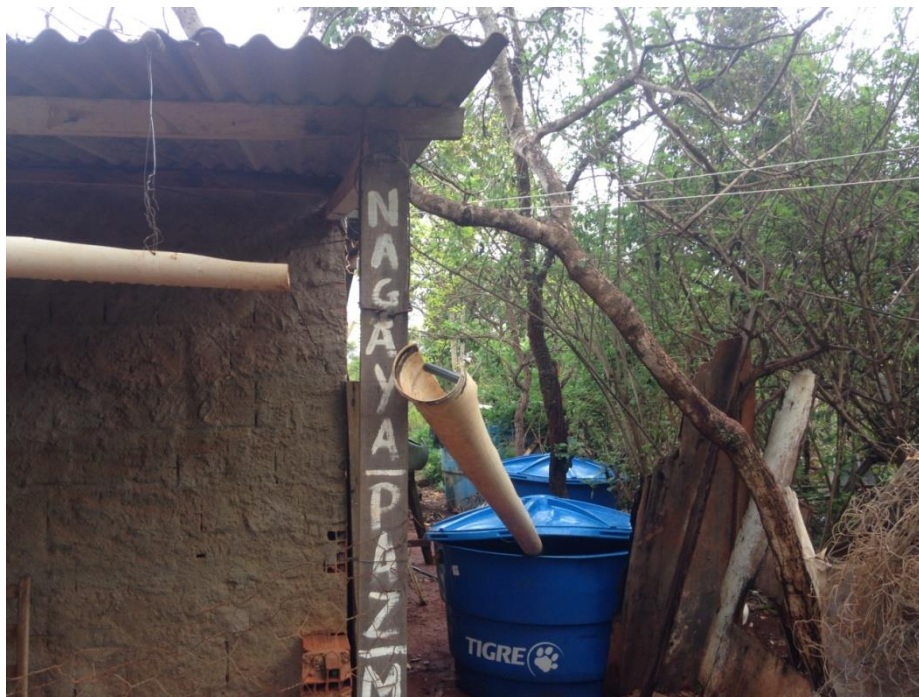
Figura 12. Armazenamento de água da chuva e água deixada pelo caminhão pipa.
