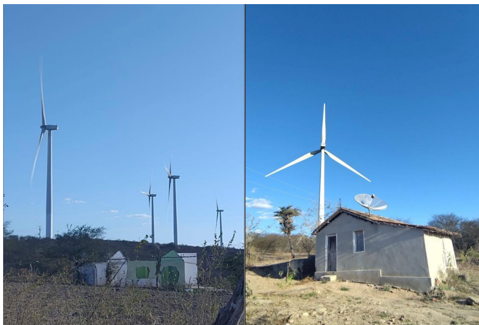
Figura 17 - Casas abandonadas após indenização do terreno em razão da proximidade com torres eólicas
