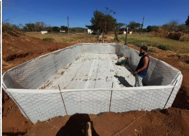
Montagem da estrutura para receber a massa
