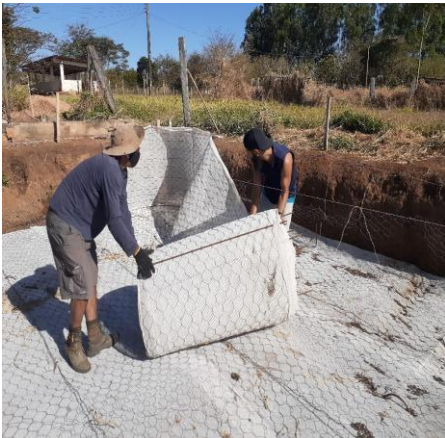
Montagem da estrutura para receber a massa
