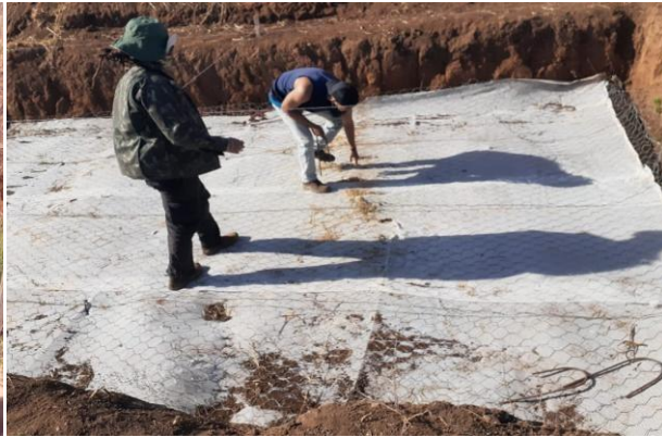
Processo de montagem da tela com sombrite e ferro
