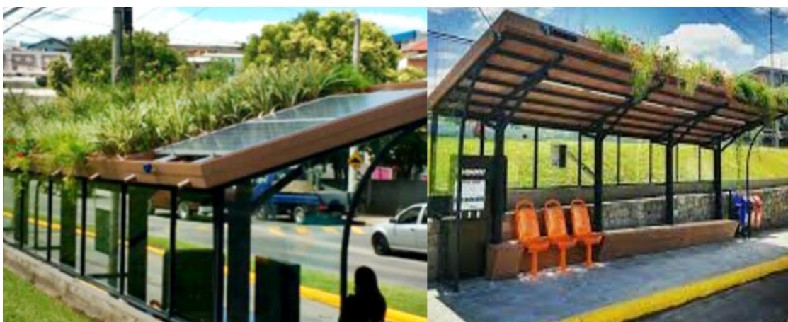
Figura: 1: Telhados verde extensivo
