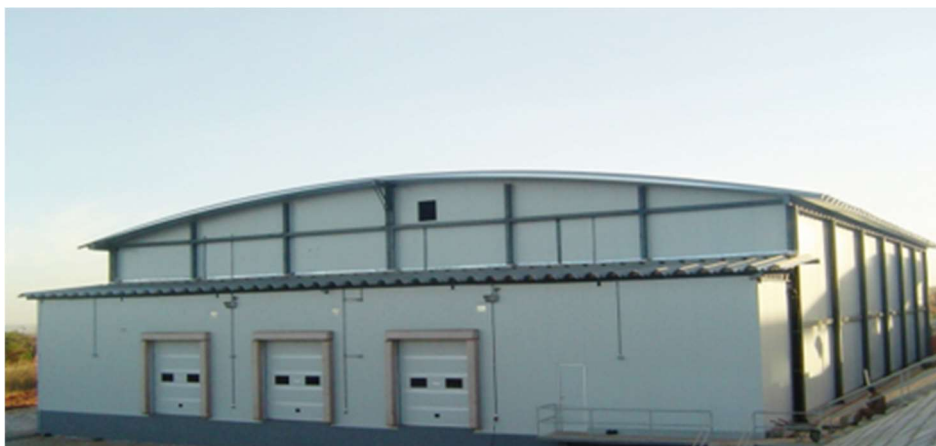
Figura 3 – Armazém Farmacêutico Refrigerado 02
