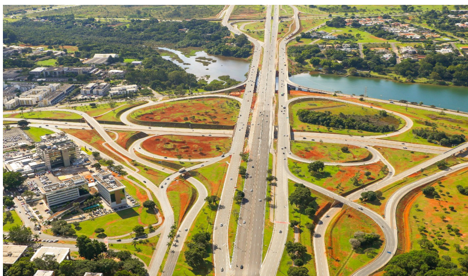
Figura 09: TTN após conclusão da obra
