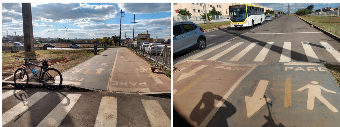
Figura 14 e 15: Início e término da ciclovia construída sobre o viaduto do Recanto das Emas.
