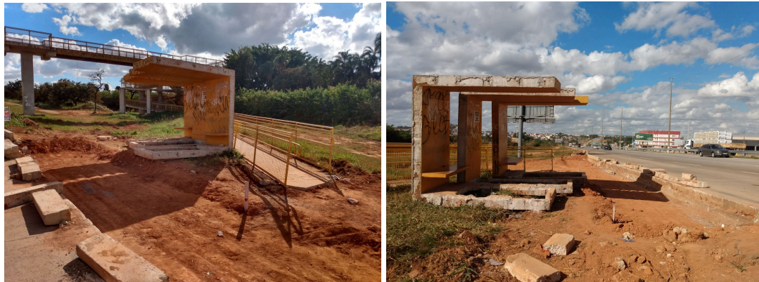
Figura 11 e 12: Ponto de ônibus na Via Estrutural, pista norte, sentido leste/oeste, altura de Vicente Pires
