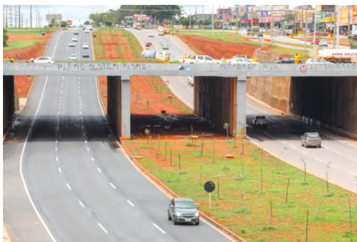
Figura 13: Viaduto do Recanto das Emas
