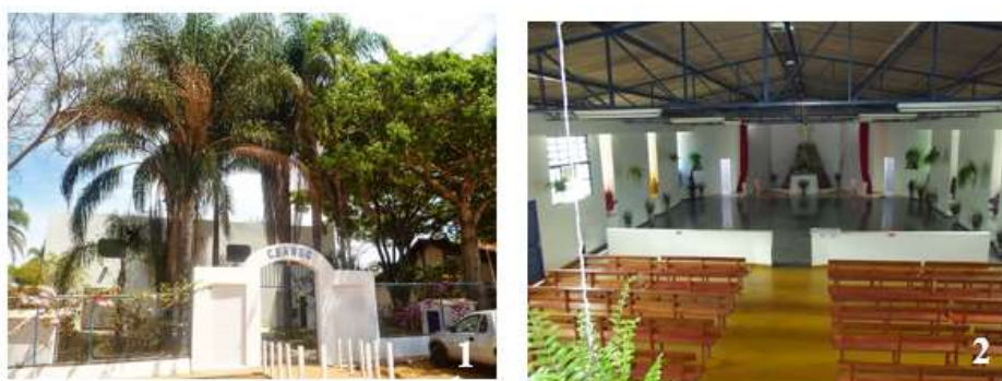
FIGURA 4: Fachada e Salão do Centro Espirita Assistencial Nossa Senhora da Glória
