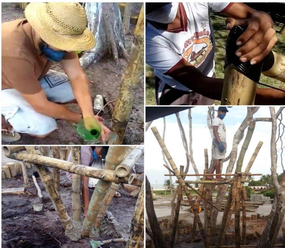
Figura 7 - Fundações e Chumbamentos das bases.
