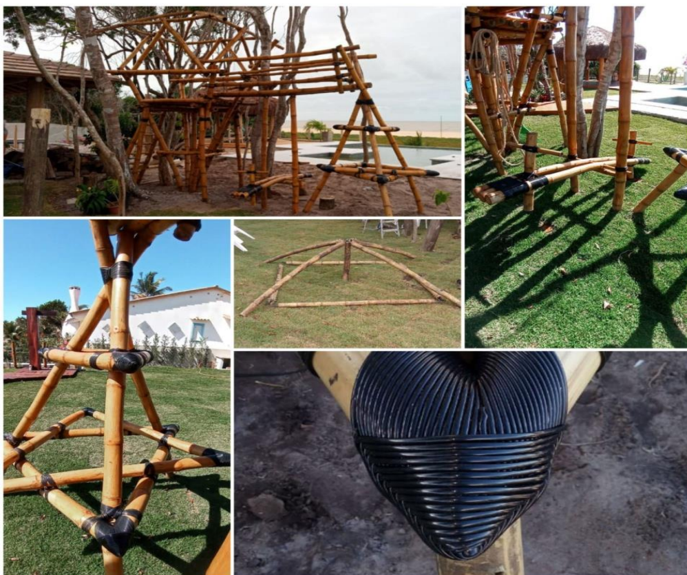
Figura 5 - Montagem da estrutura e acabamentos com amarras.
