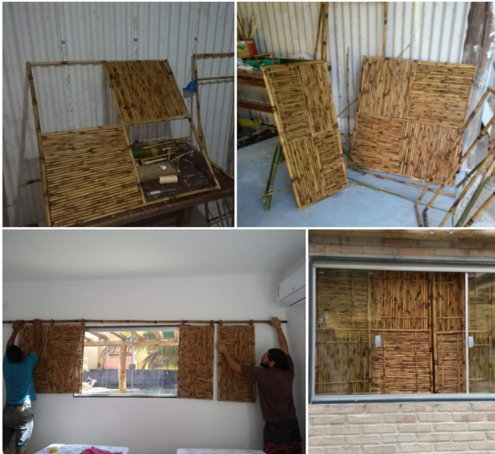
Figura 4 - Montagem e instalação de cortinas de Bambu.
