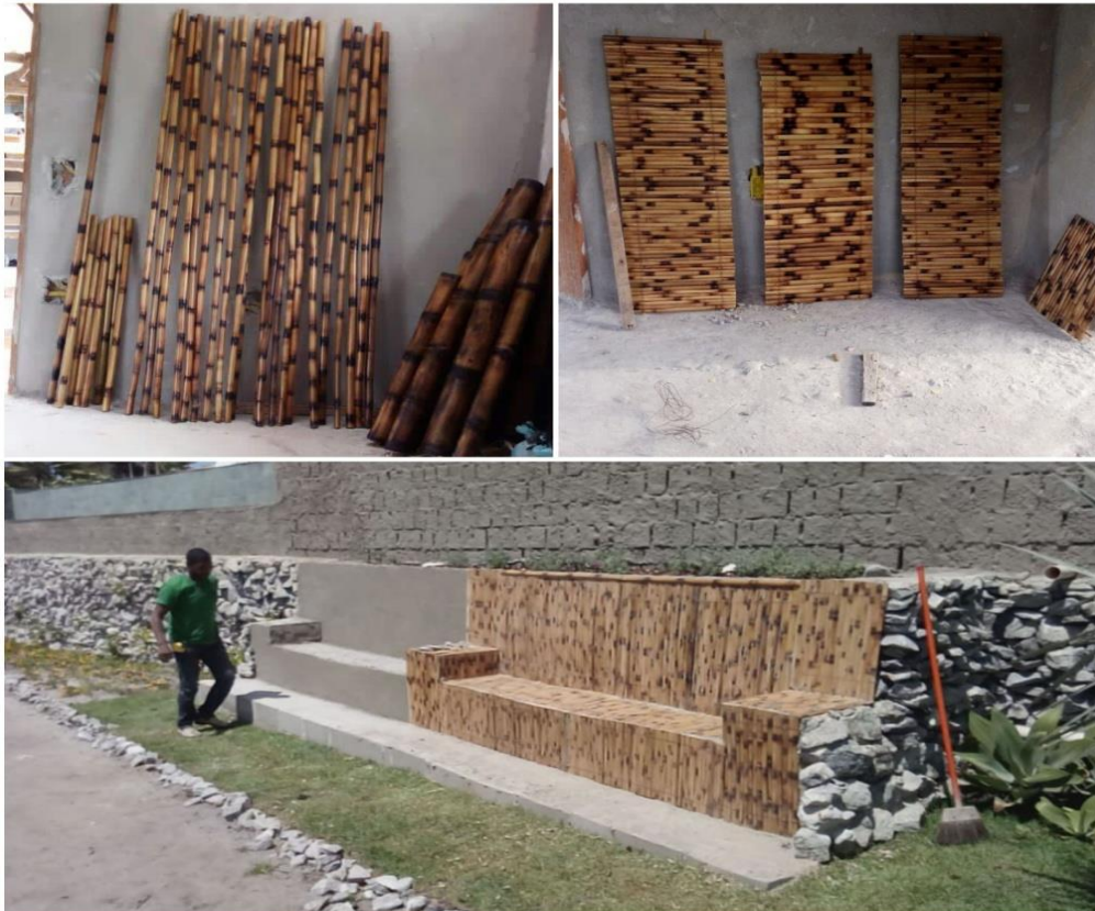
Figura 5 - Montagem dos Painéis e Instalação no banco de concreto.
