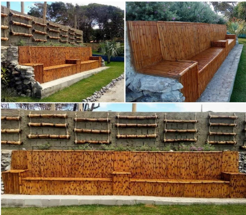
Figura 6 - Finalização do banco revestido com painéis de bambu.
