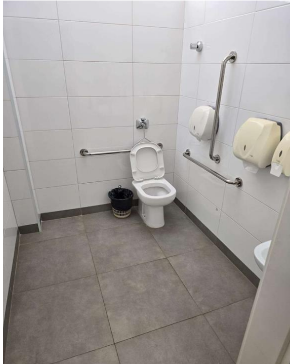
FIGURA 12. BANHEIRO PCD - PARTE INTERNA
