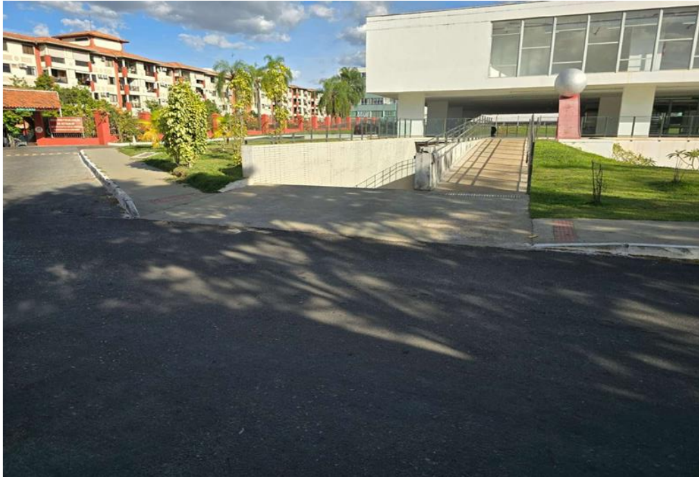
FIGURA 3. ACESSO LATERAL DO MAB
