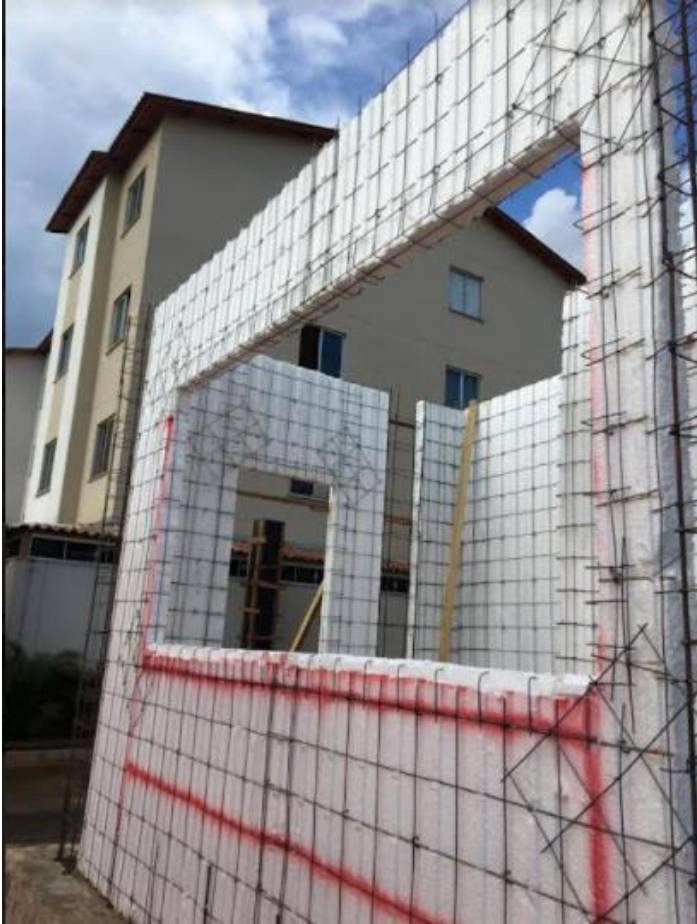
Figura 7 – Obra em andamento com EPS em paredes – Guará II-DF
