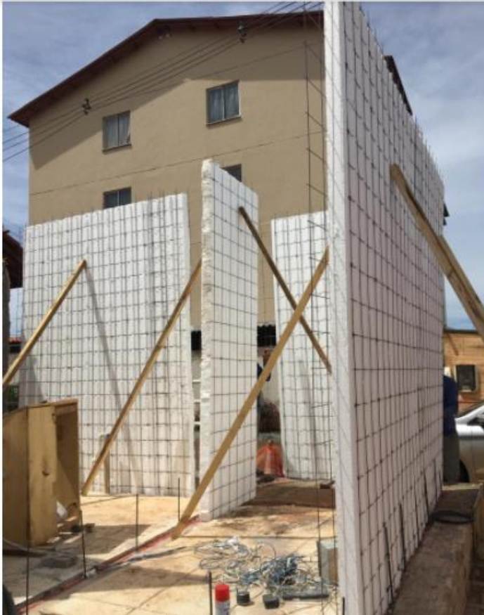
Figura 6 – Início de obra com EPS em paredes – Guará II-DF
