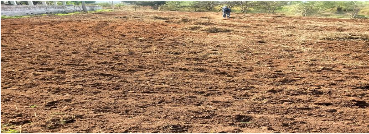
Figura 4- Remoção dos restos vegetais.
