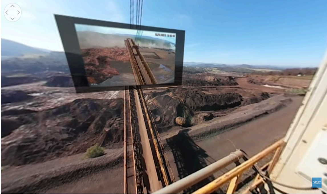
Figura 14 – Rompimento da barragem da mineradora Vale em Brumadinho – MG, 2019
