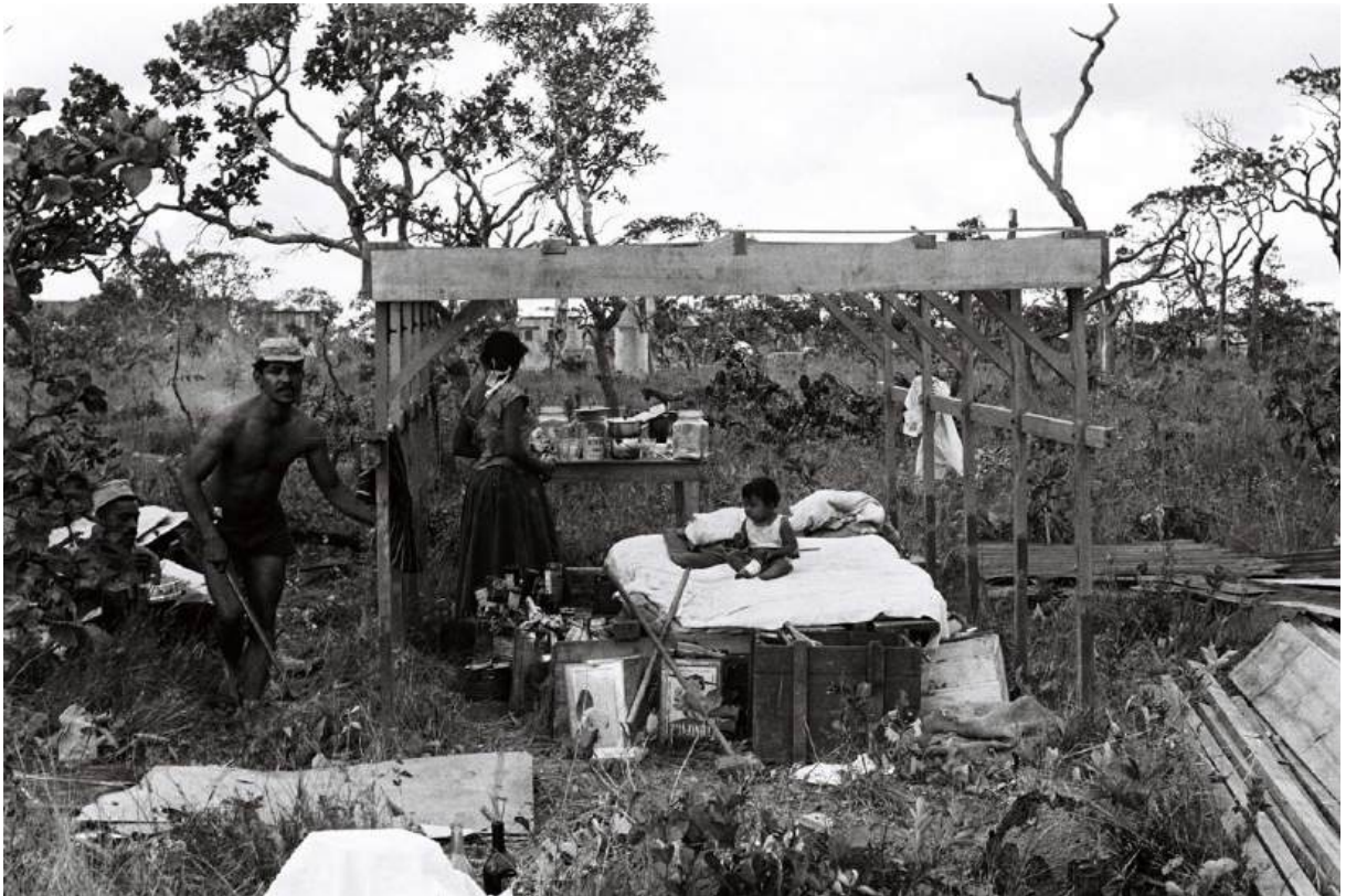
Construção de madeira no cerrado [1957-1960]. Fonte: Arquivo Público do Distrito Federal – ArPDF.
