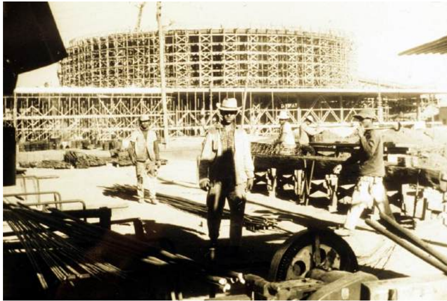
Candangos no canteiro de obras do Congresso Nacional [1958-1959]. Fonte: Arquivo Público do Distrito Federal – ArPDF.
