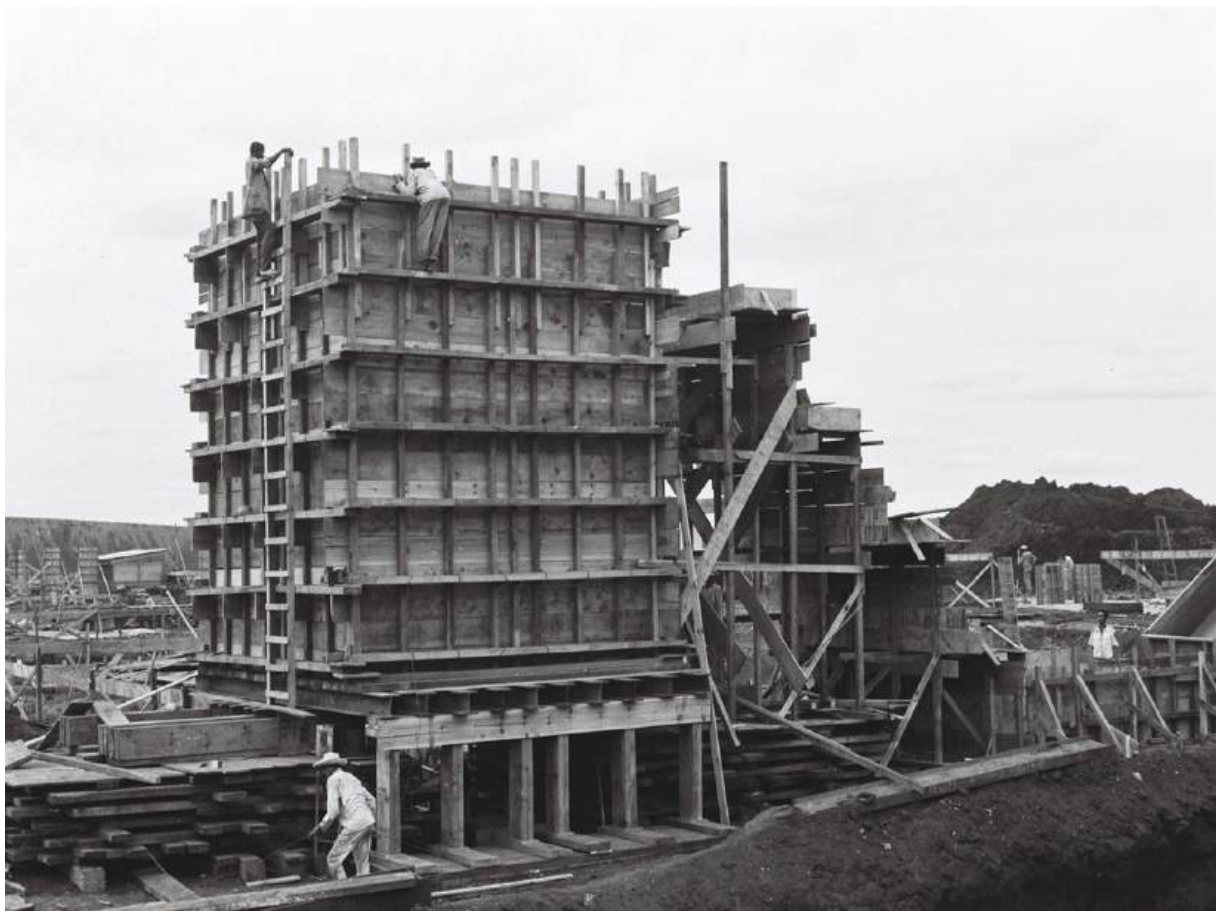
Construção do Congresso Nacional [1958]. Fonte: Arquivo Público do Distrito Federal – ArPDF.
