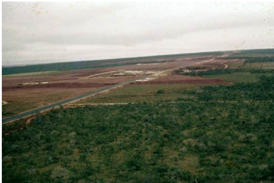
Vista aérea do início das obras e acampamento [1958]. Fonte: Arquivo Público do Distrito Federal – ArPDF.
