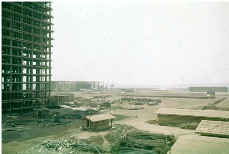
Vista do Congresso Nacional e Palácio do Planalto, ambos em construção [1958 – 1959]. Fonte: Arquivo Público do Distrito Federal – ArPDF.
