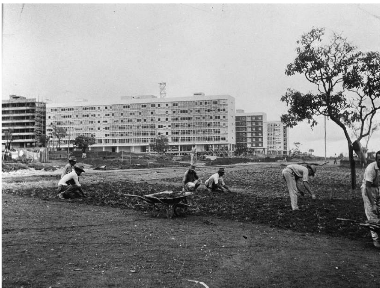
Operários trabalhando em superquadra [1957-1960]. Fonte: Arquivo Público do Distrito Federal – ArPDF.
