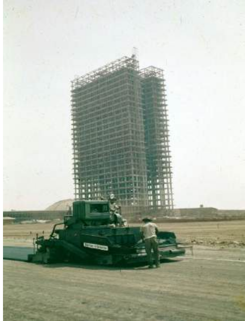
Congresso Nacional em construção [1958 – 1959]. Fonte: Arquivo Público do Distrito Federal – ArPDF.
