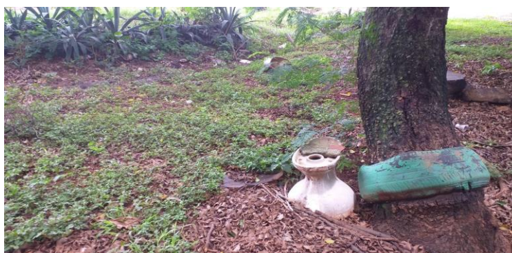
Figura 24 - SOE EQ 13/17 próximo da Escola Classe 10 - Gama (Latitude: -16.007773, / Longitude: -48.079608)
