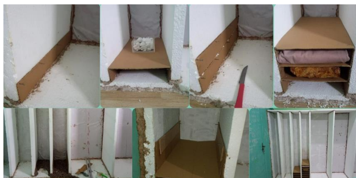
Figura 55 - Passo a passo para colocação das prateleiras
