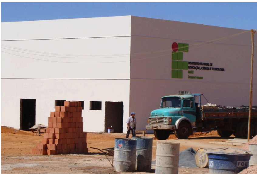
Figura 2 - IFG Campus Formosa em construção
