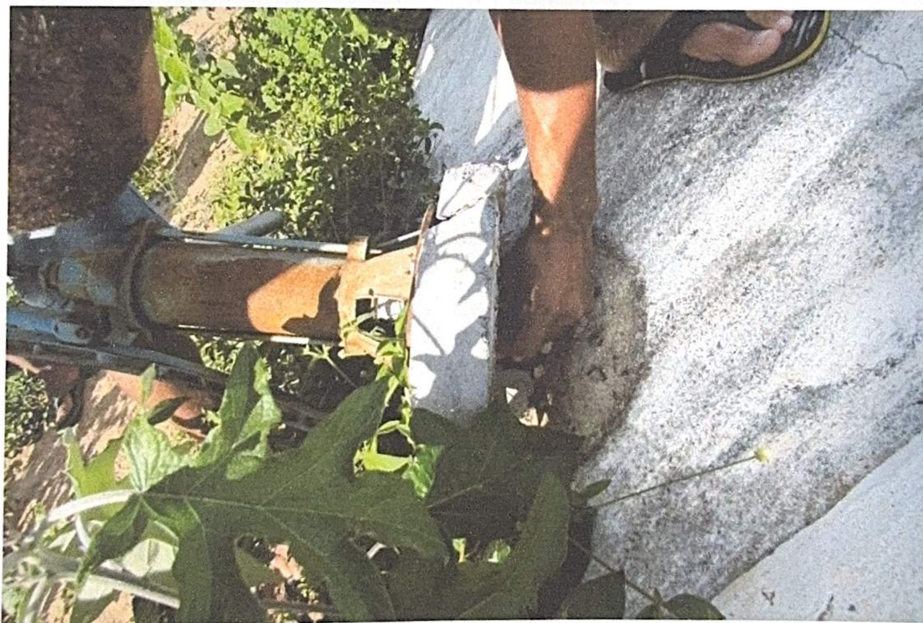
Foto 2: Bomba manual solta da conexão com a cisterna
