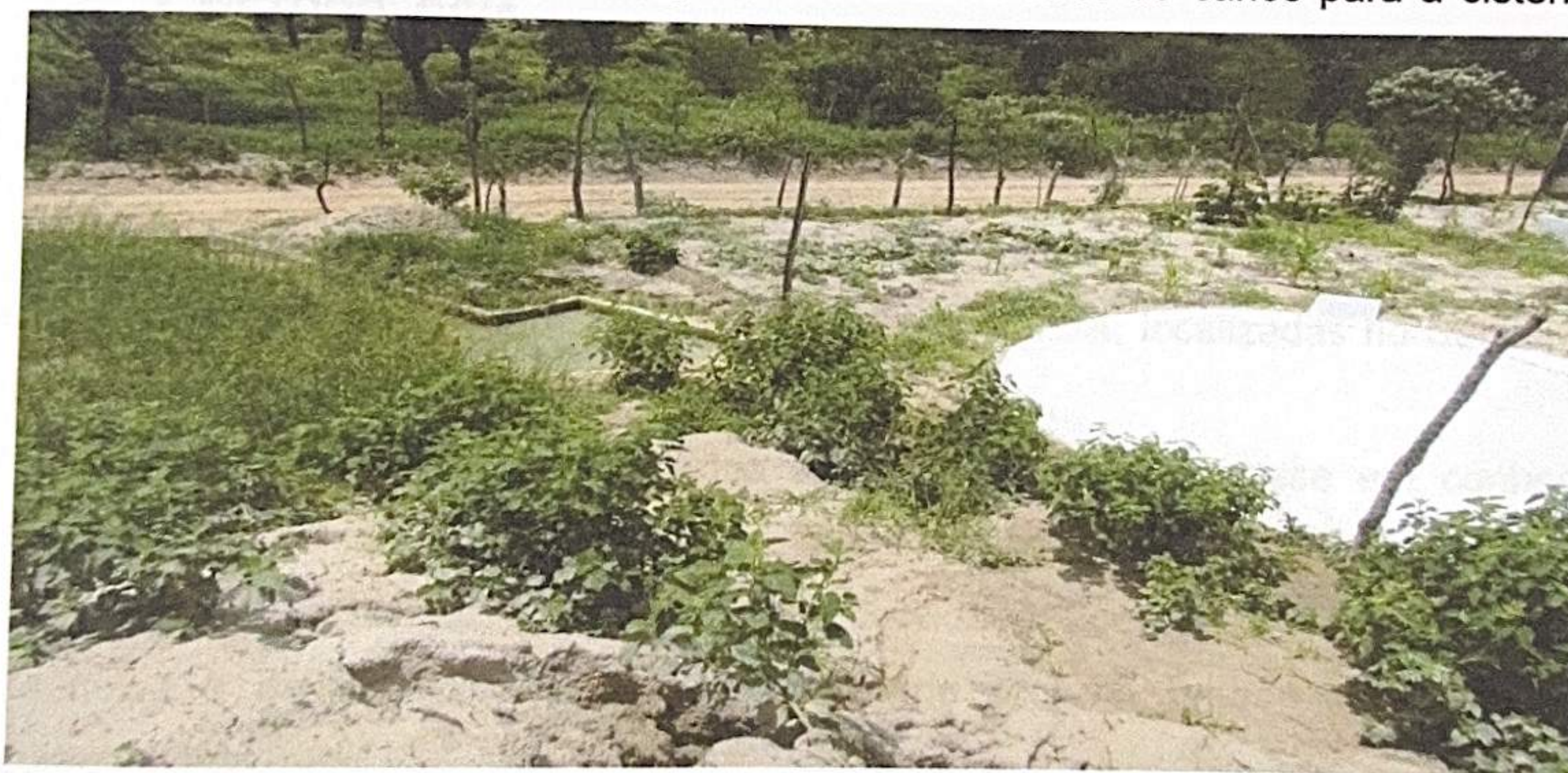
Figura 06. Cisterna de Enxurrada construída pelo P1+2 para produção agrícola comunidade Tigre, Caem - BA, 2014. Fonte: Viviane da Silva Pereira.
