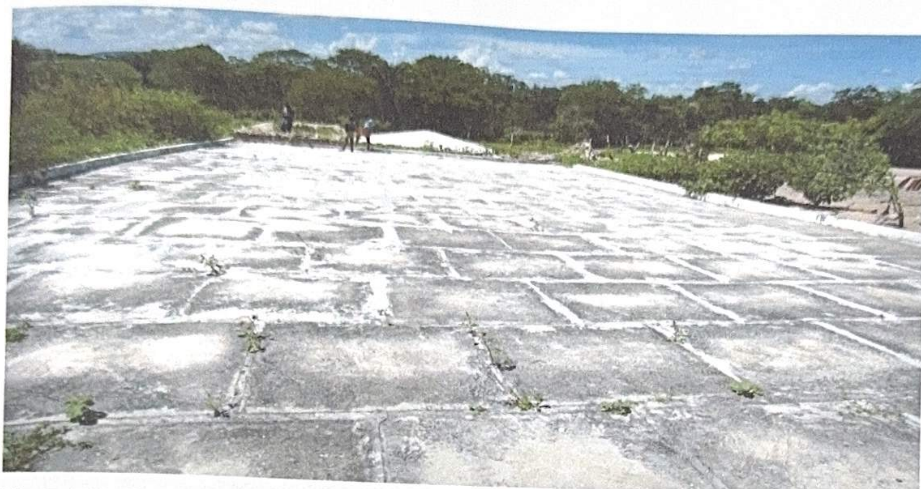
Figura 05. Cisterna de Calçadão construída pelo P1+2 para produção agrícola na comunidade Porções- Caem - BA, 2012. Fonte: Viviane da Silva Pereira.
