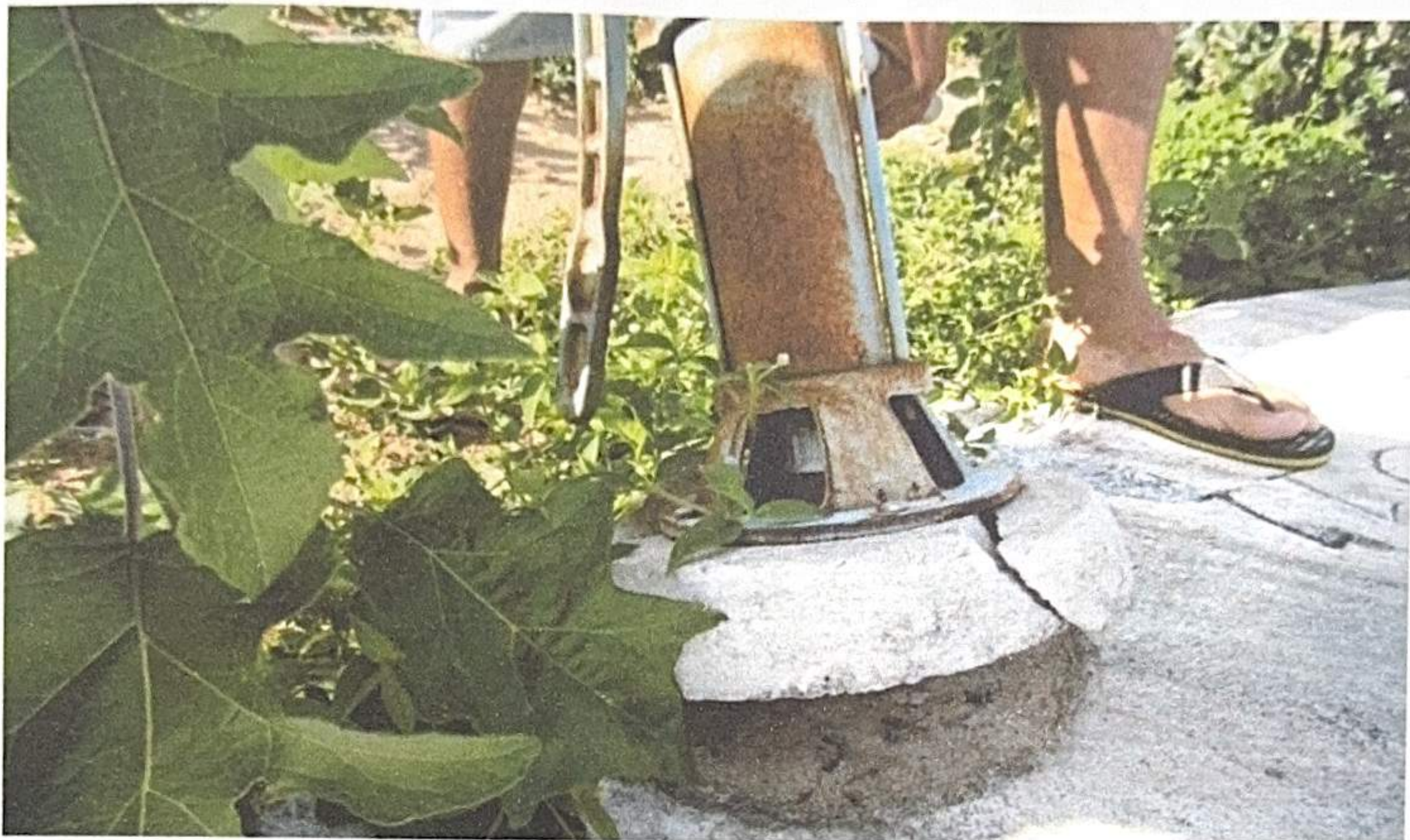
Foto 2: Bomba manual solta da conexão com a cisterna
