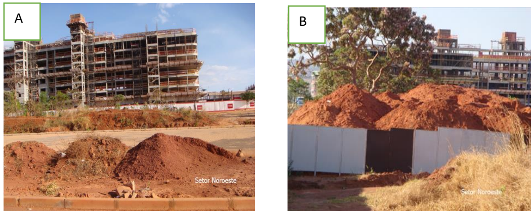
Figura 9: Fotografia (A) e (B) estocagem de terra nos canteiros de obras do Setor Habitacional Noroeste.
