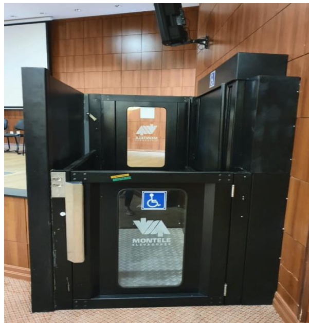
Figura 14: Elevador localizado no palco do auditório para uso de pessoas com deficiência ou mobilidade reduzida.
