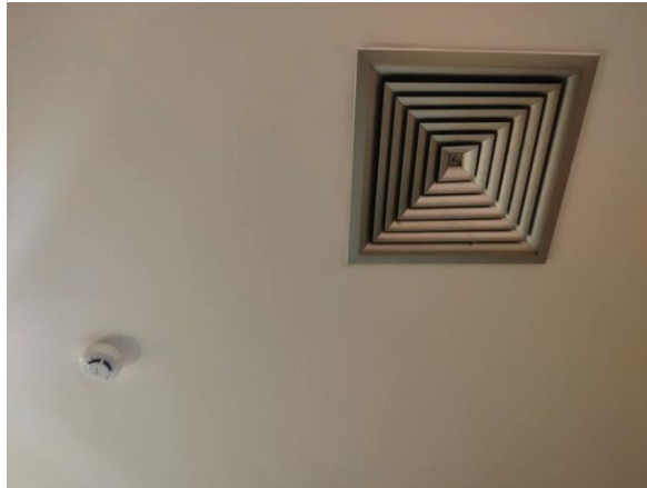
Figura 17: Dispositivo que identifica a presença da fumaça causada pelo fogo
