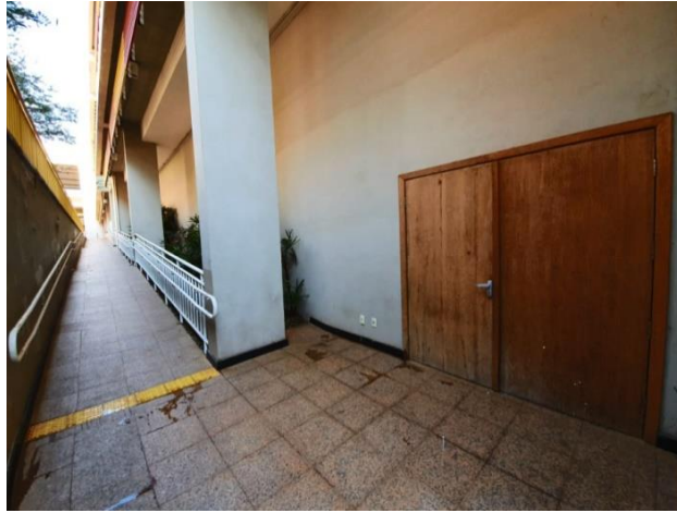
Figura 11: Rampa de acesso ao auditório, para pessoas com deficiência ou mobilidade reduzida
